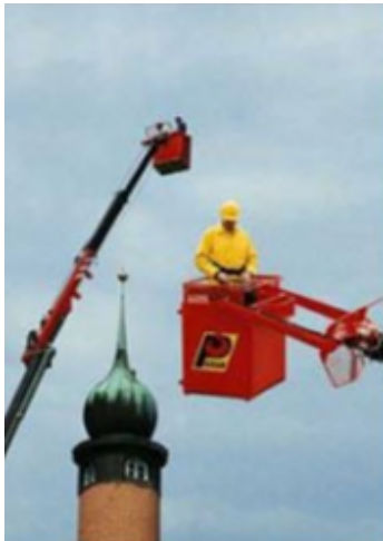
Arbeitsplattformen, die mit Ladekränen zusammengebaut sind
